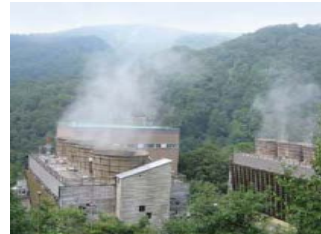
【地熱発電設備】
