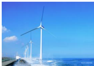
【風力発電設備】
